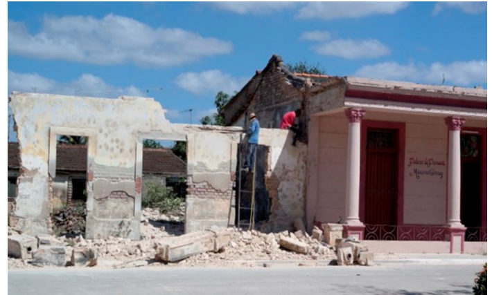
Demolición en curso
