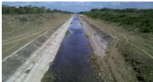
Estado actual del canal magistral
