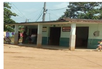
Bodega ,Cuatro Esquinas
