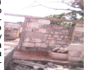
Vivienda en construcción
