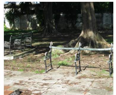
Parque colonial deteriorado
