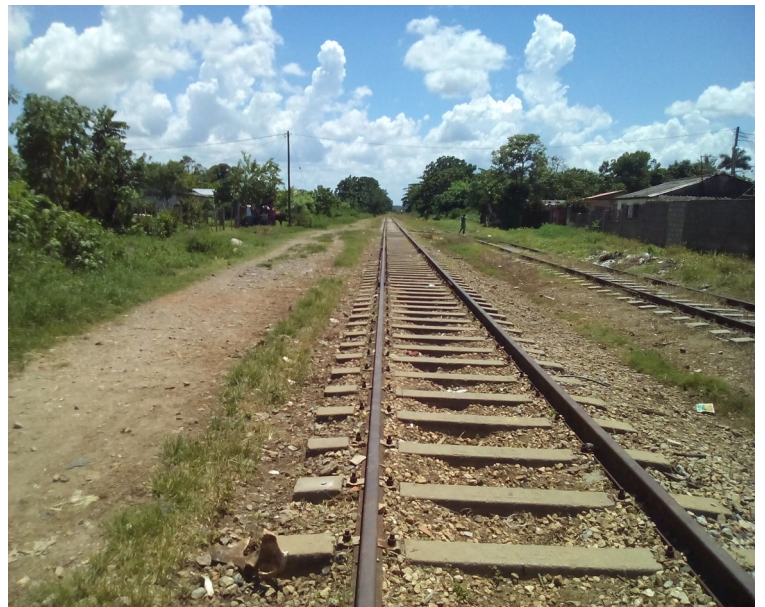
Viales en reparacion
