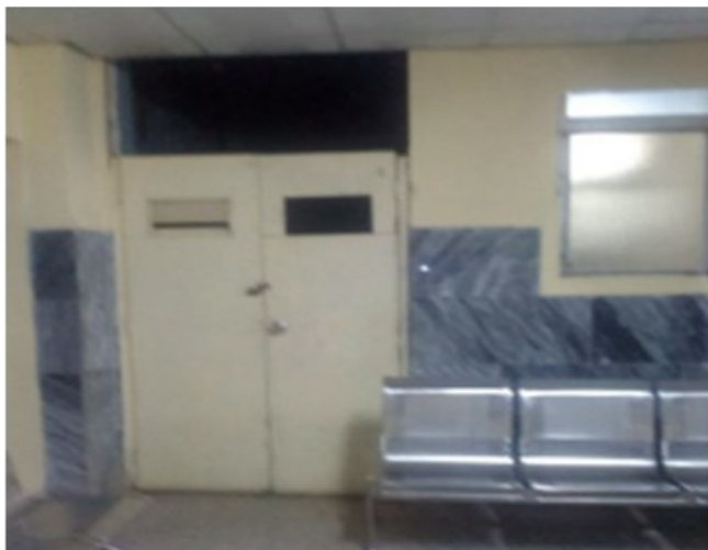
Sala del (TAC), cerrada por rotura
