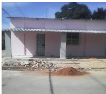
Bodega reparada. Foto: ICLEP
