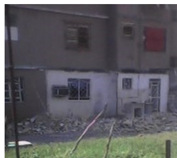
Demolición en la parte trasera del edificio 10. Foto: ICLEP
