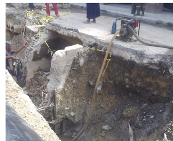
Obra de la calle Vives en ejecución
