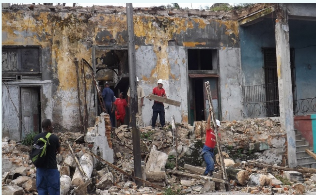
Obreros trabajando en la recogida de los escombros
