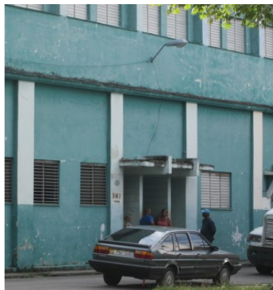
Entrada de la dirección municipal de vivienda Cerro
