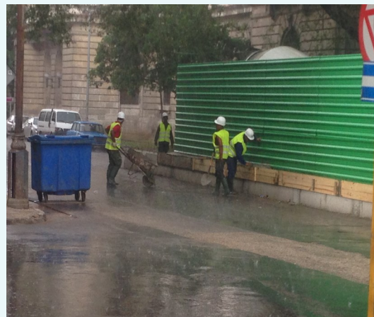
Trabajadores en función de las labores de construcción bajo la lluvia
