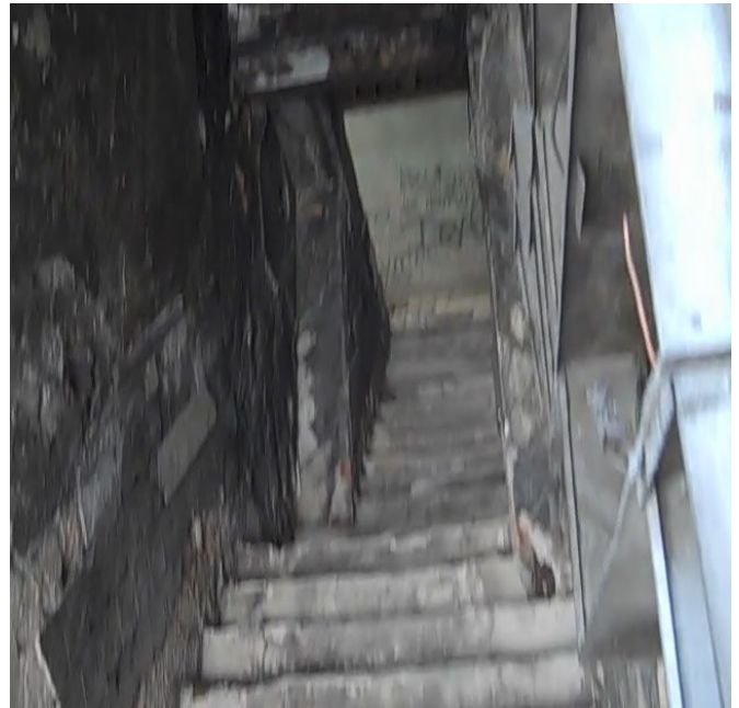
Imagen del sótano de la vivienda
