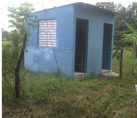
Caseta esperando por la moto bomba
