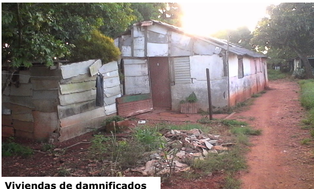
Viviendas de damnificados
