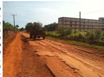
Vía de acceso al centro educacional
