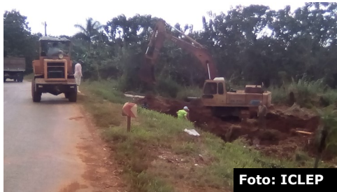
Foto: ICLEP Obreros realizando reparación en una red principal de abasto
