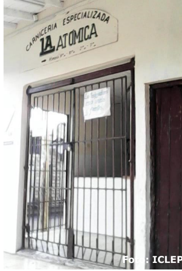
Carnicería La Atómica después de reparada.
