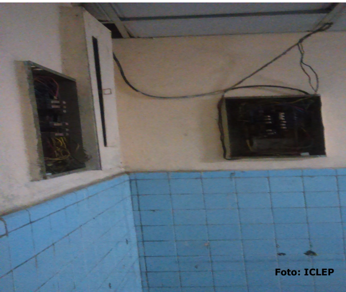
Breques de corriente expuestos sin protección.
