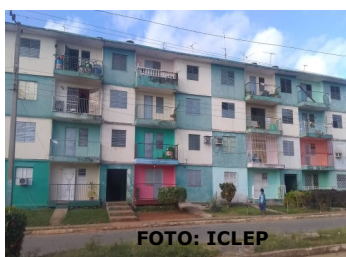
Edificio mas afectado por el desabasto de agua potable.
