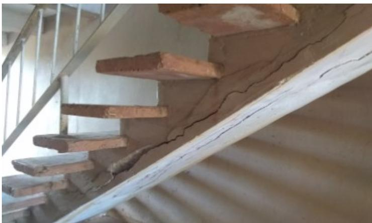
Escaleras en peligro de derrumbe, edificio 17. Foto: ICLEP
