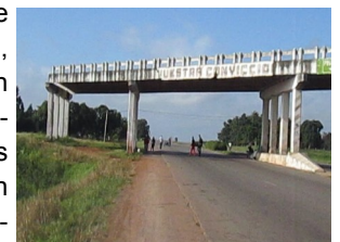
Imagen del puente sin terminar
