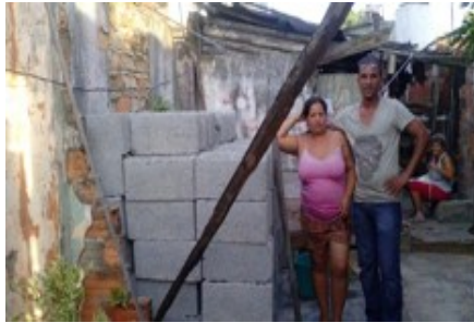
Mayelín con parte de los materiales que le entregaron para la reparación de su vivienda.
