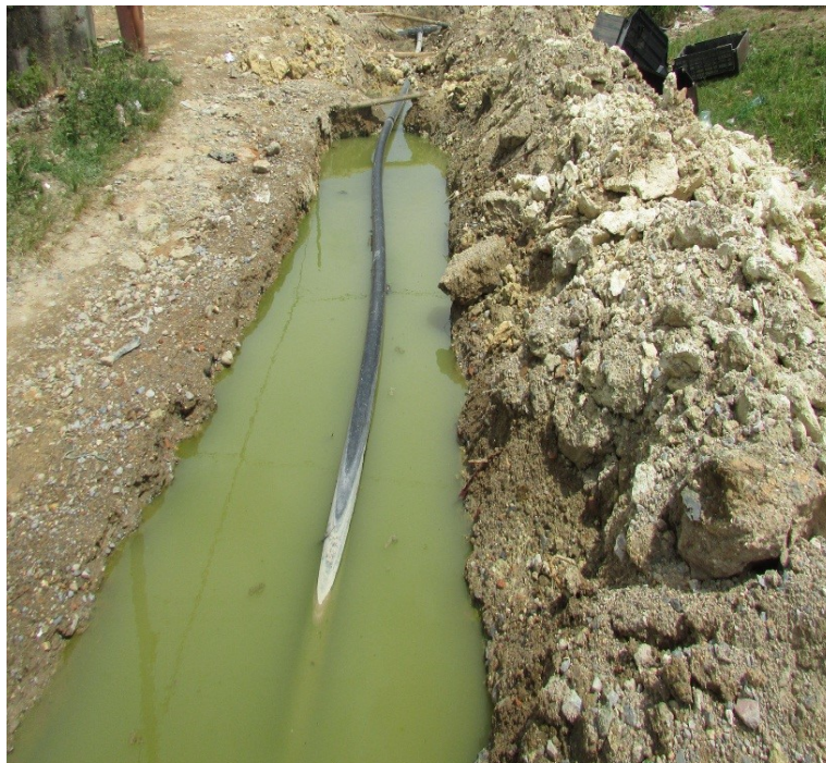
Vista de la zanja abierta en Calle segunda del reparto Lázaro acosta
