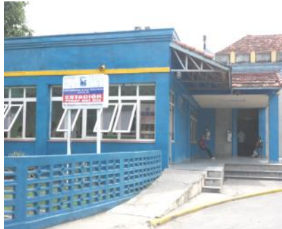
Terminal de Trenes de la ciudad pinareña
