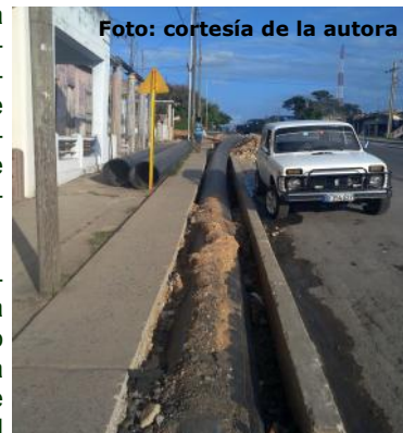
Zanja en Calle Alameda
