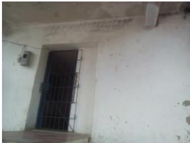
Oficina de Acueducto
