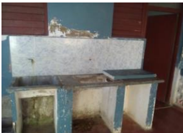
Meseta exterior de la instalación. Boca de Galafre.
