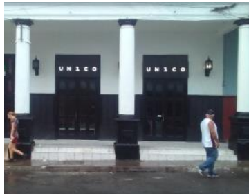
Foto: ICLEP Nueva fachada del establecimiento comercial.
