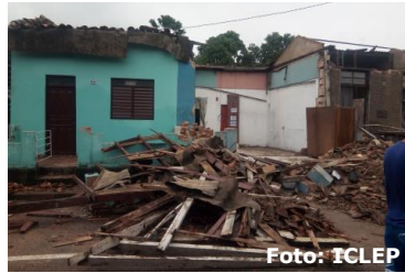
Foto: ICLEP Hogares totalmente derrumbados por el paso del huracán Michael en Pinar del Río.
