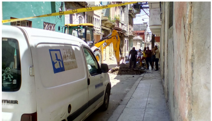
Imagen de los trabajadores en sus labores de reparación
