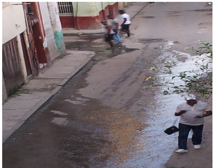
Imagen de aguas albañales corriendo por las calles
