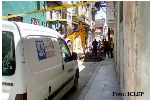
Imagen de la reparación
