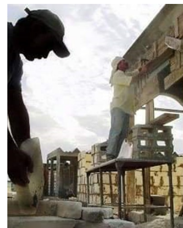
Damnificados del tornado de febrero pasado aún esperan por que se reparen sus viviendas (Foto ICLEP).
