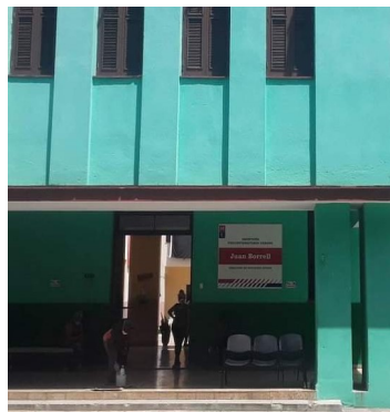
Centro de aislamiento Juan Borrell. Foto: ICLEP
