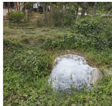
Salidero de Agua: Foto ICLEP
