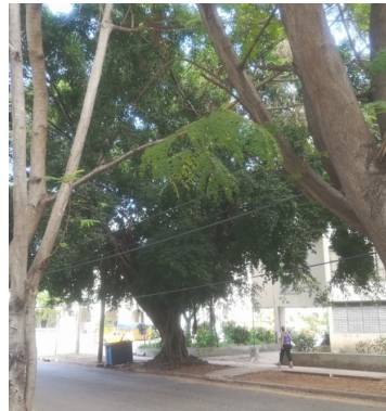
Tendido eléctrico. Foto: ICLEP
