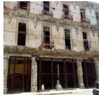
Edificios 707 y 709. Foto: ICLEP
