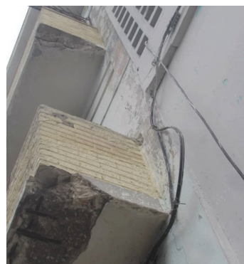
Edificio 1 005. Foto: ICLEP
