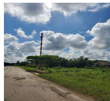
Torre de comunicación de ETECSA: Foto ICLEP
