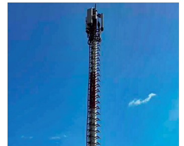
Torre telefónica de ETECSA. Foto: ICLEP
