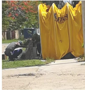
Reparación, calle 277. Foto: ICLEP
