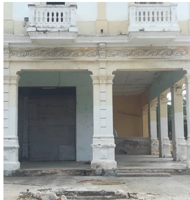
Bodega asaltada, calle 63 entre 98 y 100, Marianao. Foto: ICLEP
