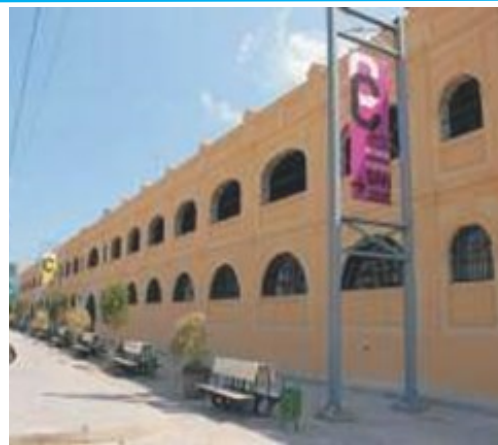
Almacenes San José del puerto habanero. Foto: EcuRed
