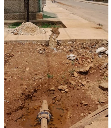
Tubería en reparación. Foto: ICLEP
