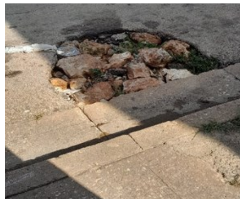
Hueco de la calle 42. Foto: ICLEP
