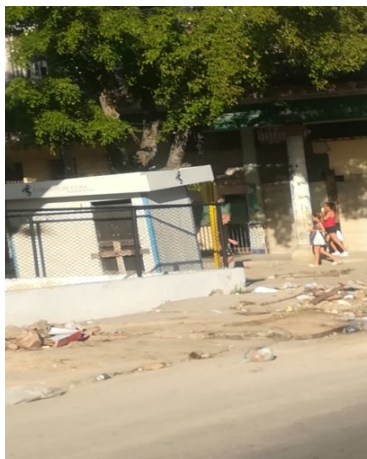
Calzada de Luyanó y Manuel Pruna, 10 de Octubre. Foto: ICLEP
