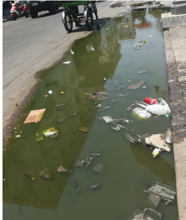
Salidero en la esquina de Galeano y San Rafael, en el municipio Centro Habana. Foto: ICLEP
