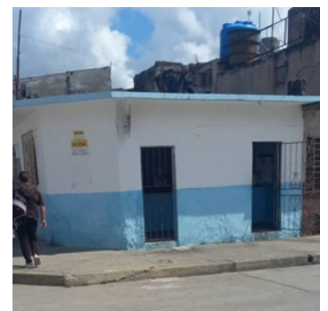
Bodega. Foto ICLEP
