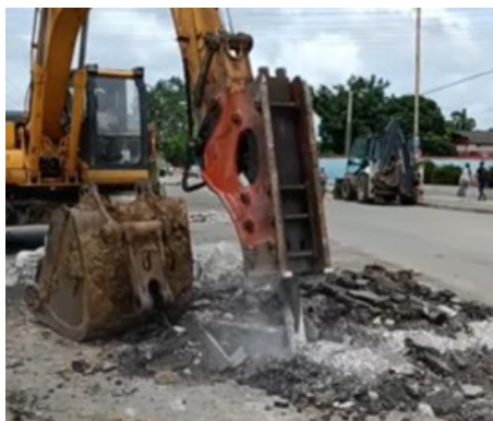
Construcción de la nueva rotonda. Foto ICLEP
