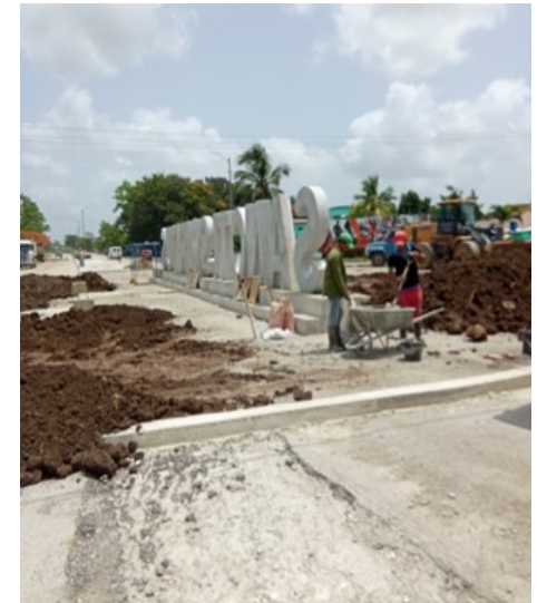
Construcción de la nueva rotonda 12. Foto ICLEP
